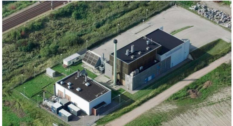
Figuur 20 Biomassacentrale in Lelystad (De groene energiesite , n.d. )
